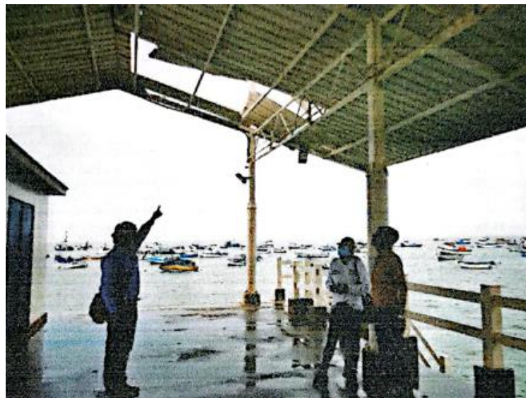
Foto N° 06: Afectación en el DPA Cancas
